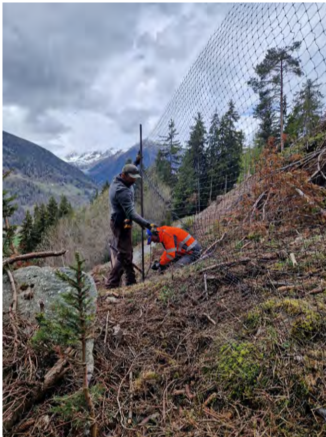
Erstellung des Zaunes und Verankerung mittels Eisenpfosten.
